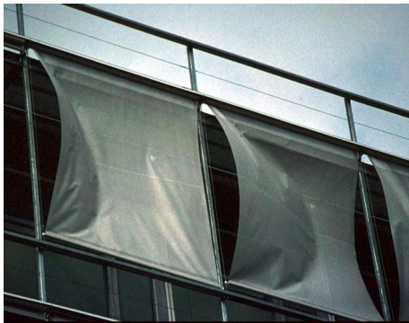
Textiler Sonnenschutz ist in der Regel nicht für eine Dauerbeanspruchung durch stärkeren Wind ausgelegt.
